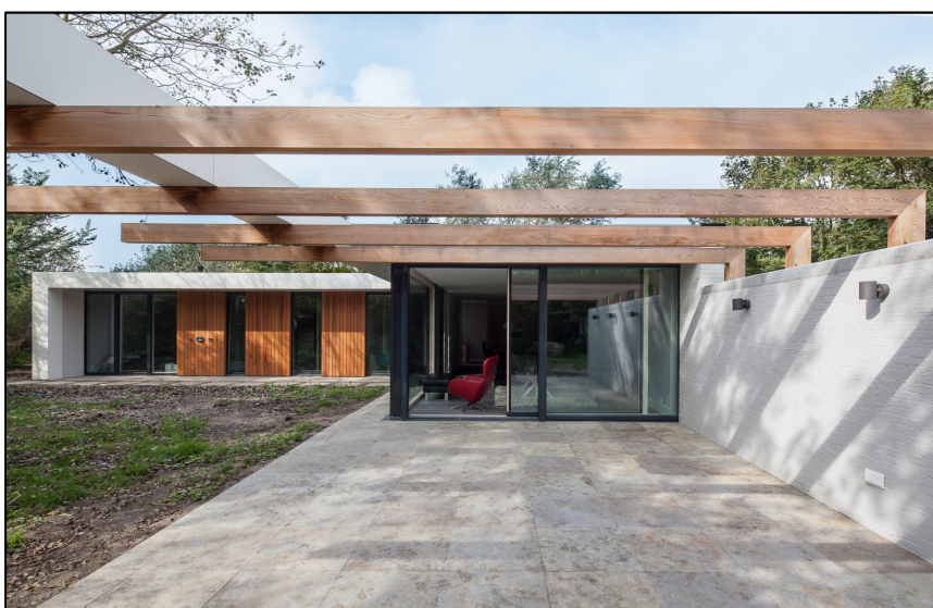
Schuifpui van Smartwin met een U_w van 0,8 W/m 2 K.
